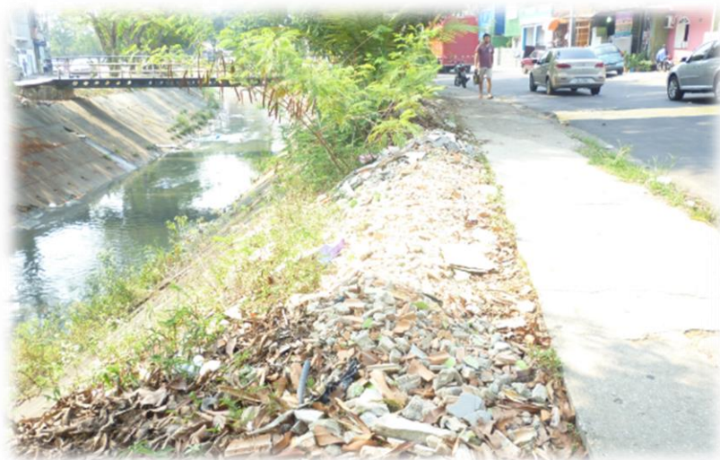
Figura 24 - Resíduos da Construção Civil Despejado ao Redor do Igarapé
