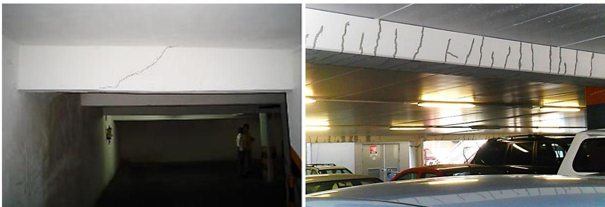
Figura 1.1 - (a) Fissura em viga do Edifício Areia Branca, dias antes do desabamento (b)
