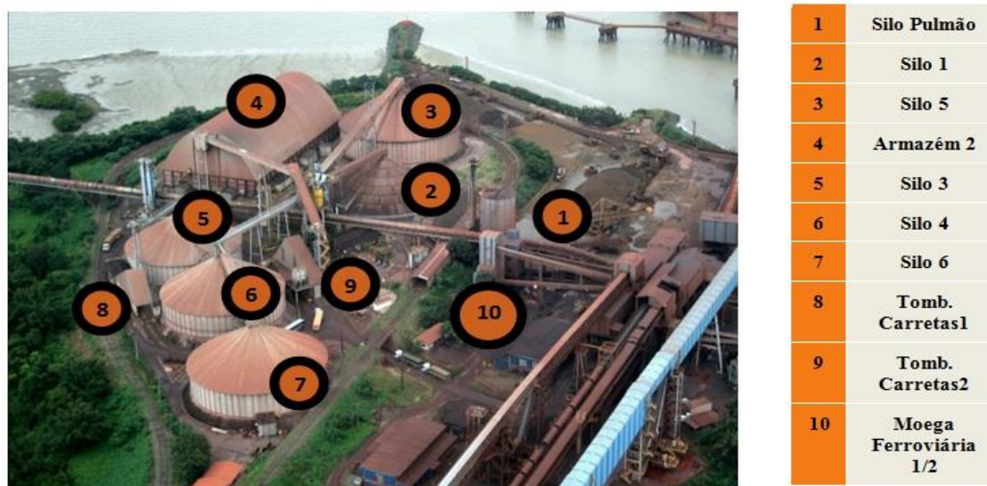
Figura 3.5 - Visão detalhada do TPSL.
