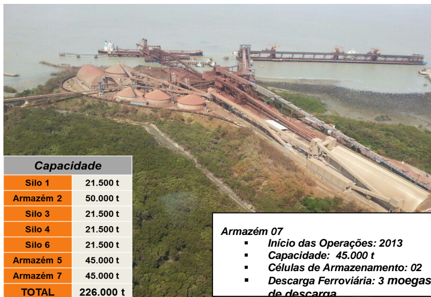
Figura 3.6 - Visão do armazém 7/moega 3.
