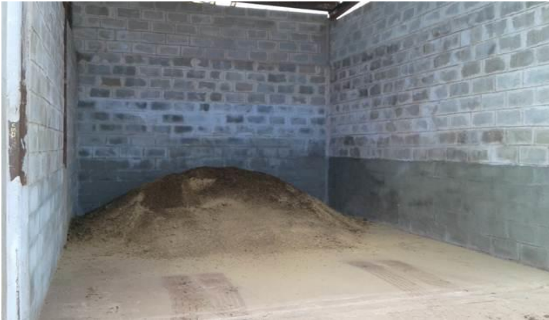
Figura 4.9 - DIR com resíduo de soja aguardando para destinação final: compostagem/blendagem.
