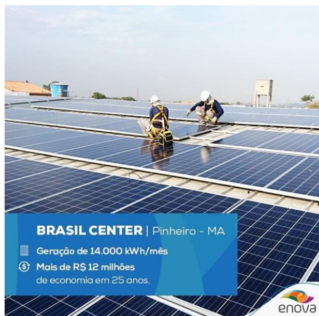
Figura 2.15 - Edificação Brasil Center em Pinheiro. Fonte: ENOVA (2018).
