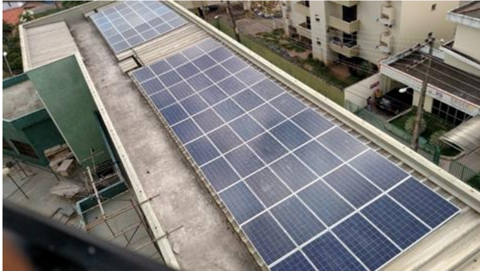
Figura 3.2 - Oitenta painéis instalados no Bloco G no HUUFMA. Fonte: NOBREGA (2016).
