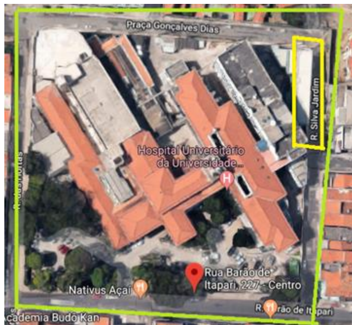
Figura 3.3 - Destaque em amarelo o Bloco G com os painéis FV instalados e área disponível para possível expansão.
