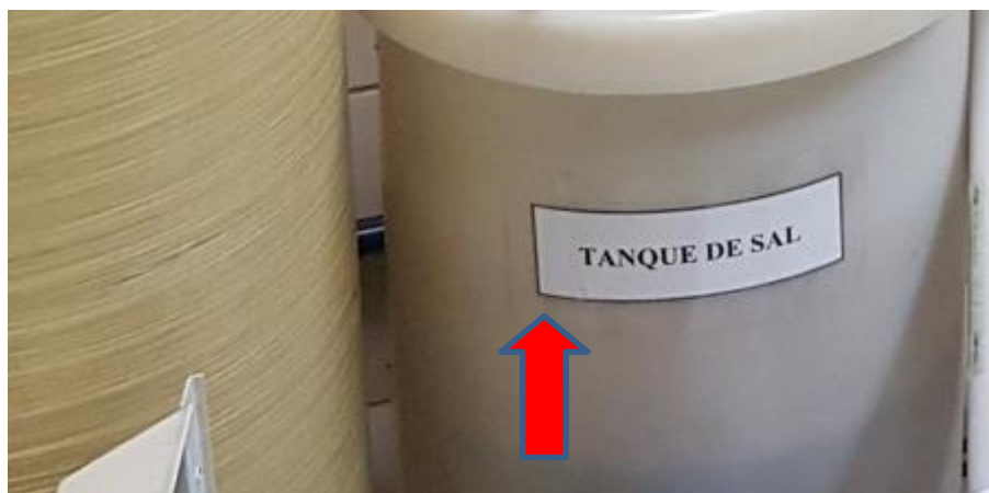
Figura 2.5 – Tanque de salmoura
