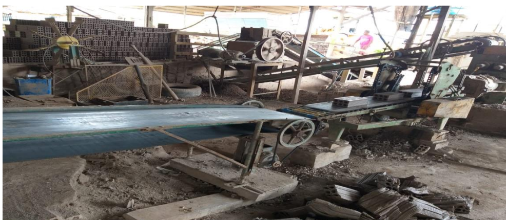
Figura 4.16 - Entulhos no ambiente laboral.
