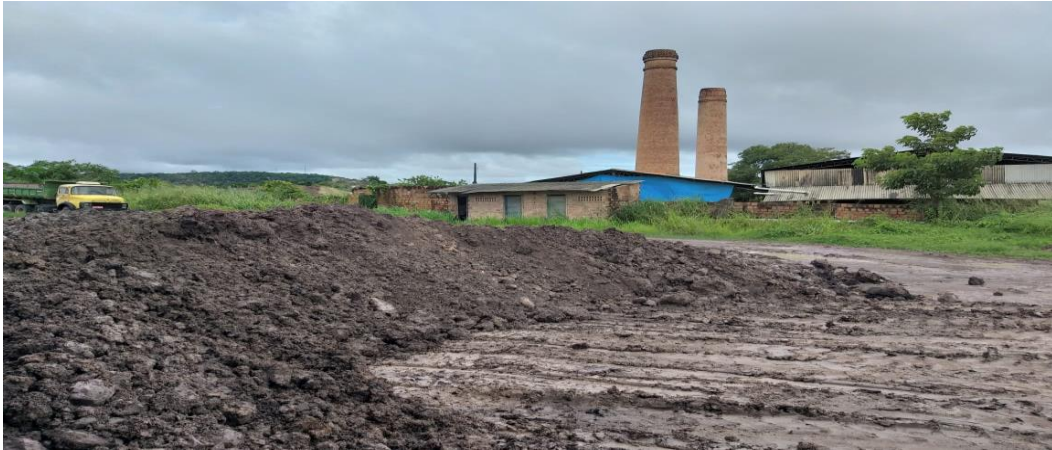
Figura 4.2 - Local onde a matéria prima é despejada.
